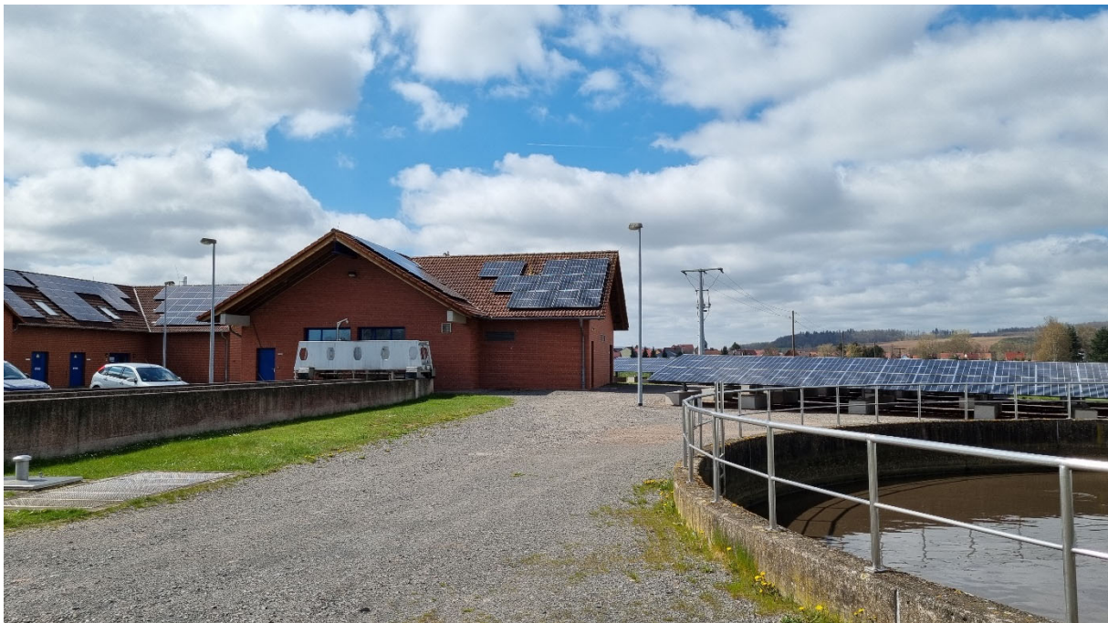
Abb.: PV-Anlage KA Bernterode mit Dach- und Freiflächen-Anlage
